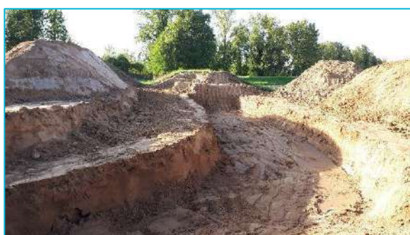
Fondation de la digue de Port-Sainte-Marie
