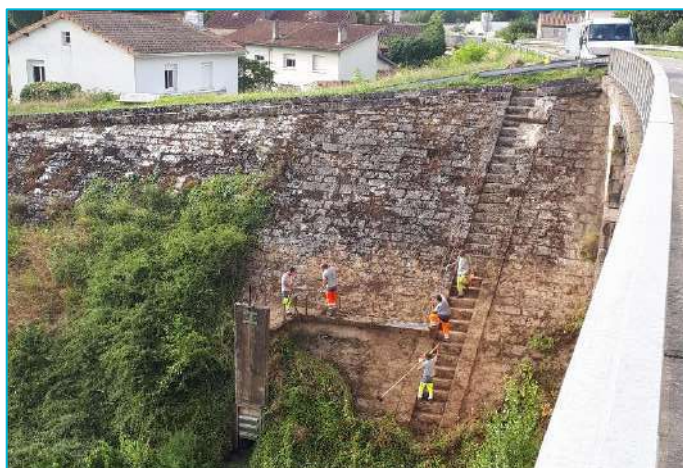
Travaux d'entretien de la digue d'Aiguillon - Côté Lot
