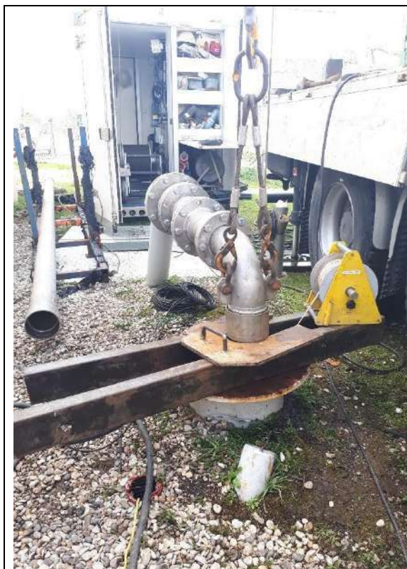
Forage de Lagravette à Lafitte sur Lot
