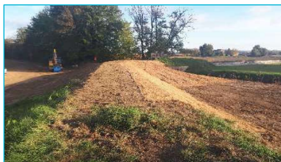
Digue reconstruite de Port-Sainte-Marie
