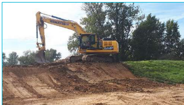
Travaux sur la digue de Port-Sainte-Marie
