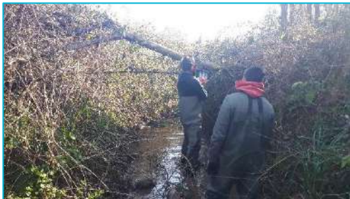
Ouverture du lit d'un cours d'eau
