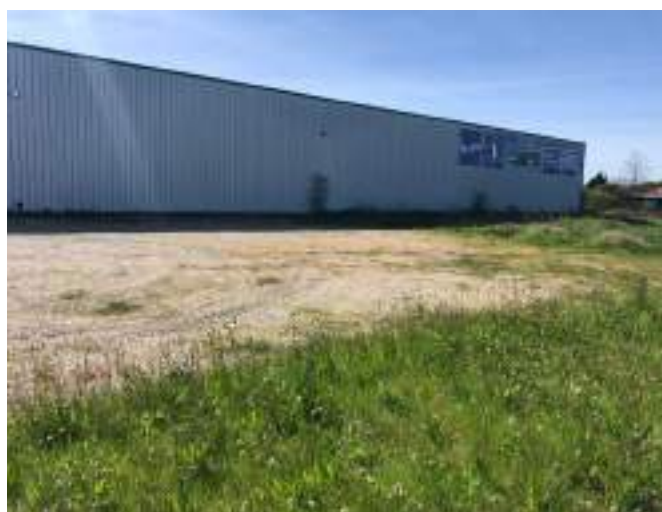
Photographie de la zone rudérale (05 avril 2023)
